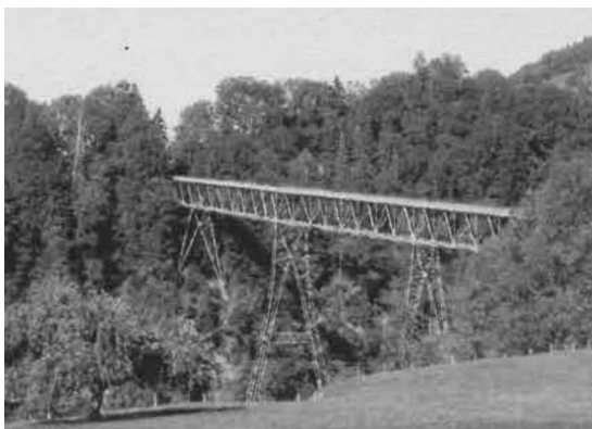
Blick von der Steiner Seite auf die sanierte Brücke. Foto HPB 2011
