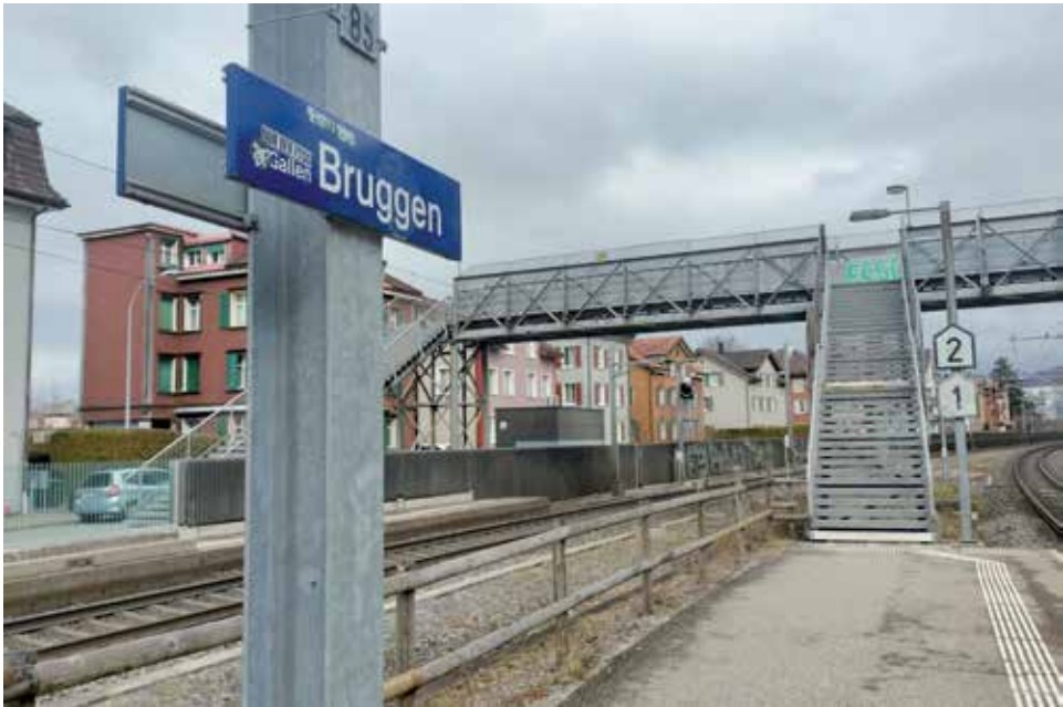
Die Passerelle beim Rickenweg muss dringend saniert werden. Quelle: Foto Damian Diethelm.
