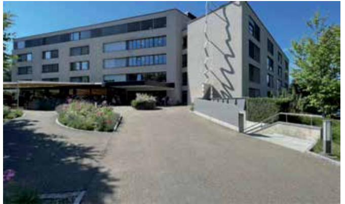
Das Pflegeheim Bruggen nach der Totalsanierung und der Erweiterung um einen Anbau in den Jahren 2012 und 2013.
