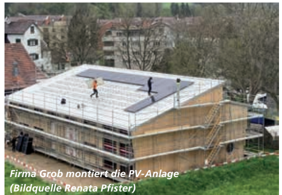
Firma Grob montiert das Blechdach (Bildquelle Renata Pfister)
