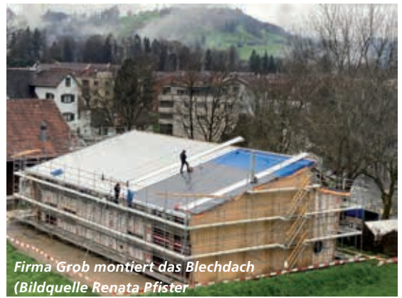
Frühling auf der Baustelle
