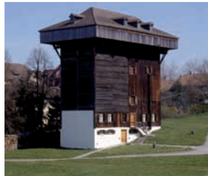
Der Tröckneturm nach seiner Renovation 2003, StadtASG, PA Foto Gross, E16283.
